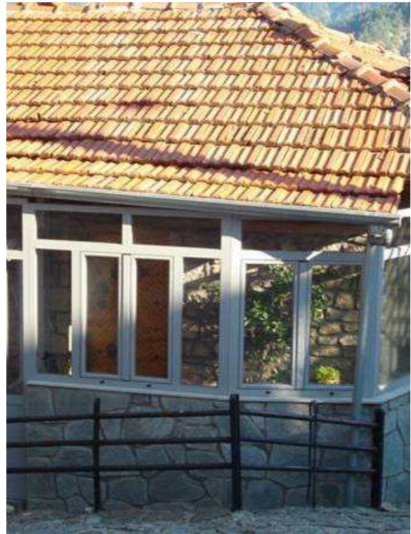
Εικόνα 3: «Κλείσιμο» Ημιυπαίθριου Χώρου με Αλουμινοκατασκευή Photo 3: Abolition of Semi-open Space with Aluminum
