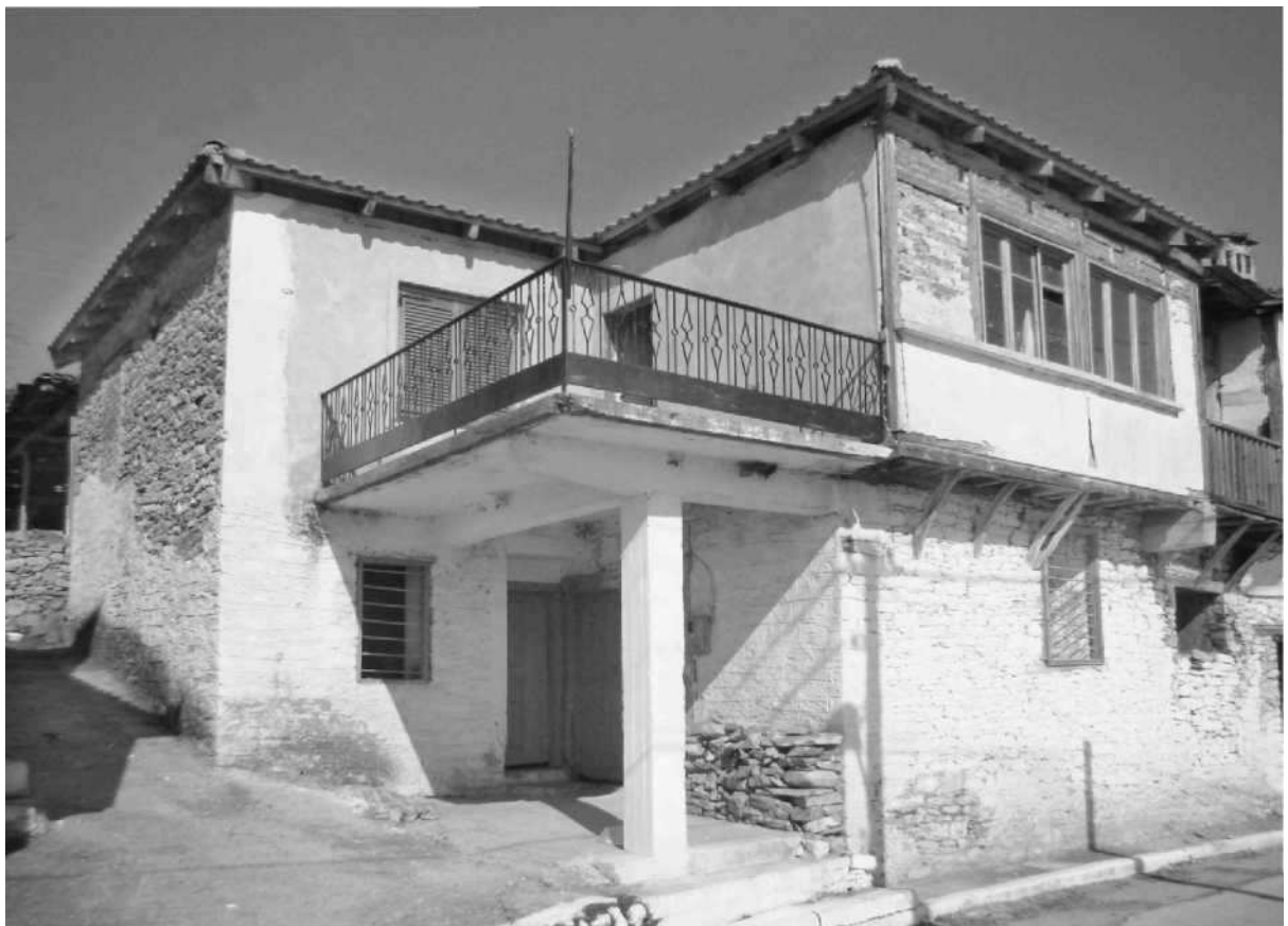
Εικόνα 14. Κτίσμα 4. Άποψη από το νότο. Photo 14. Residence 4. South view.
