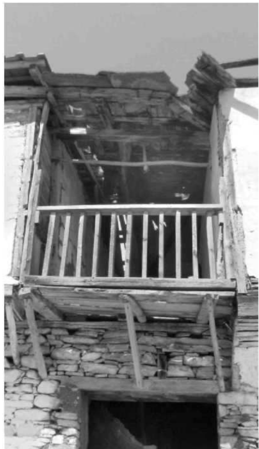
Εικόνα 4. Κτίσμα I. Λεπτομέρεια. Photo 4. Residence 1. Detail.
