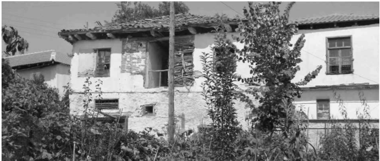
Εικόνα 5. Κτίσμα 2. Άποψη από το νότο. Photo 5. Residence 2. South view.
