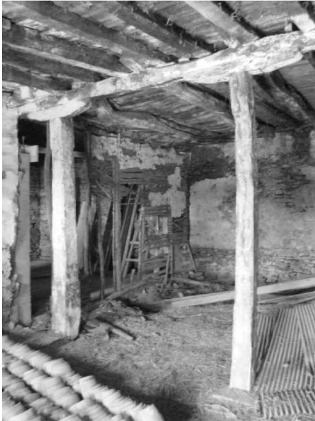
Εικόνα 8. Ξύλινα υποστυλώματα στο ισόγειο κατοικίας. Photo 8. Wooden pillars in a residence ground floor.
