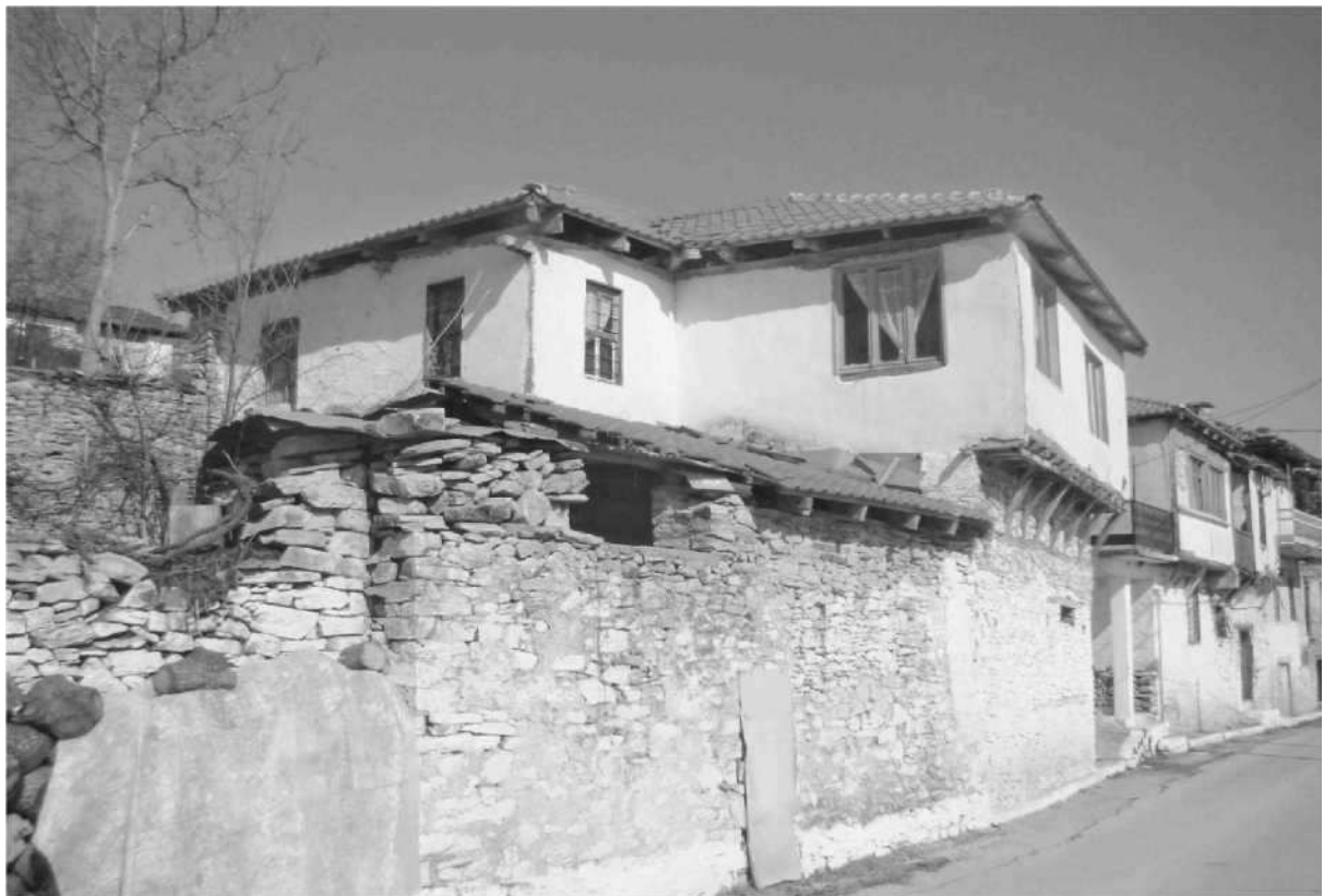
Εικόνα 15. Κτίσμα 5. Άποψη από το νότο. Photo 15. Residence 5. South view.
