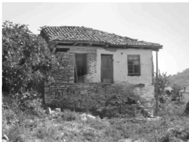
Εικόνα 6. Κτίσμα 2. Άποψη από τα δυτικά. Photo 6. Residence 2. West view.
