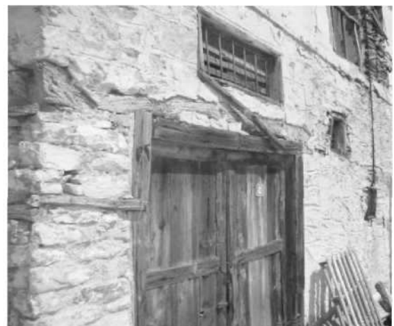
Εικόνα 7. Κτίσμα 2. Λεπτομέρεια. Photo 7. Residence 2. Detail.
