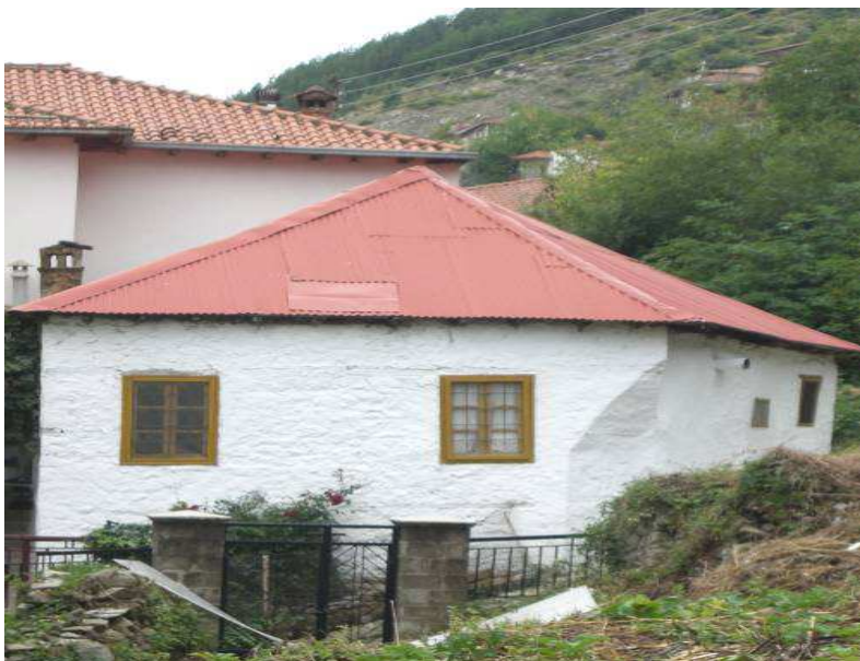
Εικόνα 12. Οικία (Εικόνα 1- 08) δυτικά του Αγίου Χαράλάμπους Foto 12 House (F. 1 -08) West of Aghios Charalampos
