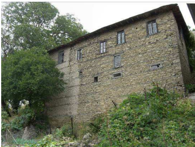
Εικόνα 6. Οικία (Εικόνα 1- 04) στο ΝΔ άκρο του οικισμού Foto 6. House (F. 1- 04) SW part of the settlement
