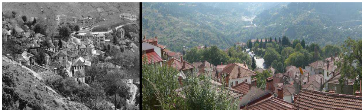
Εικόνα 20 α, β. Αλλοίωση της αρχιτεκτονικής φυσιογνωμίας του οικισμού. α. φωτ. 1934(αρχείο Καλή Θεά , www.kali-thea.com 4/12/2006) β. υπάρχουσα κατάσταση
