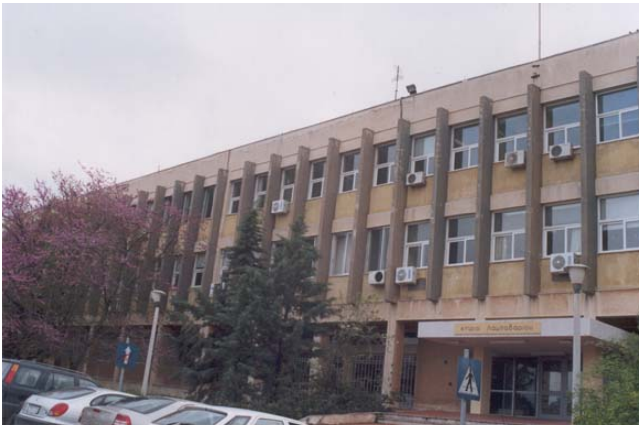
Βόρεια όψη του κτιρίου «Λαμπαδάριο»
